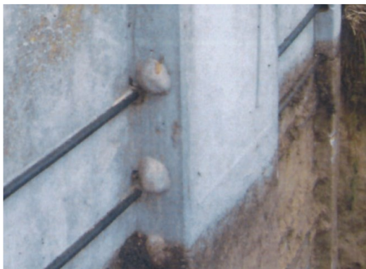
Foto 26. Indstøbt forankring
