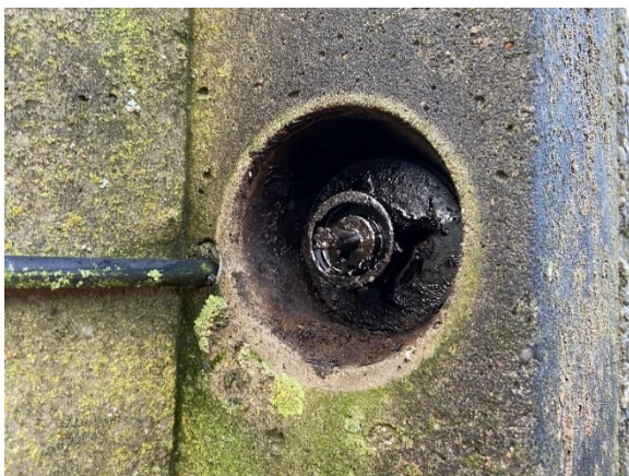
Foto 27. Lås på Muleby beholder med dækkende overfladebehandling.
