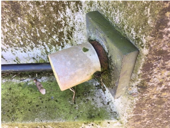
Foto 15. Afdækning på Perstrup beholder, hvor fugemassen mangler og der ses korrosion på låsehus.
