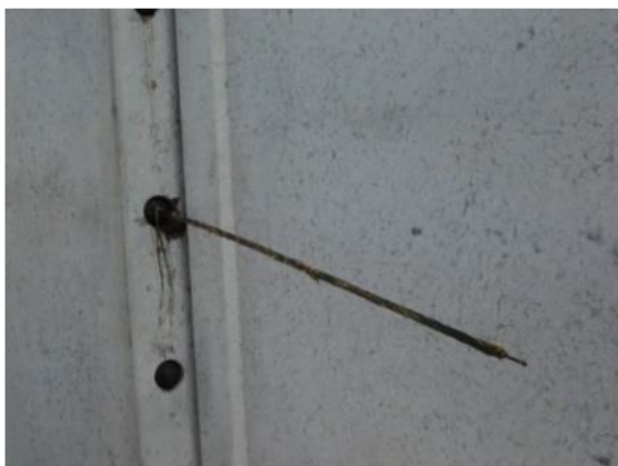
Foto 1. Sprungen kabel.
