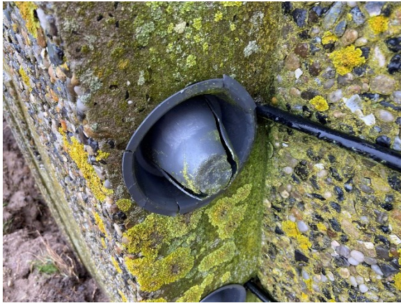
Foto 32. Beskadiget afdækningshætte på Muleby beholder.
