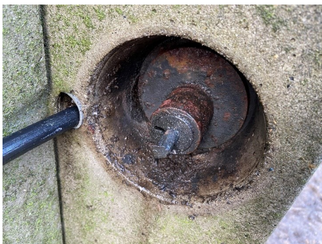
Foto 3. Korrosion på stålede.
