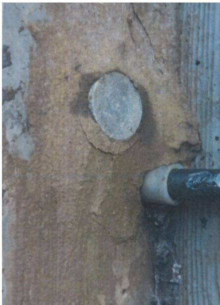
Foto 25. Indstøbt forankring/lås.
