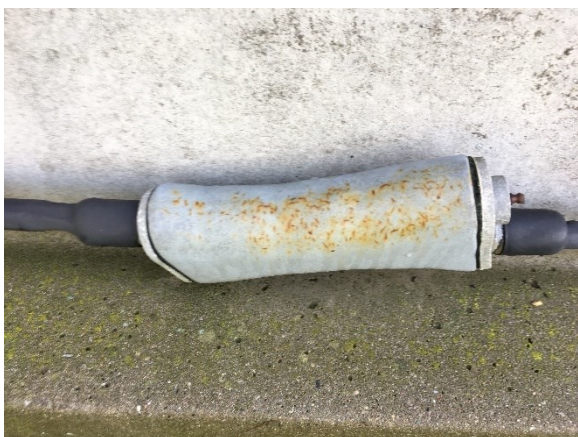
Foto 21. Mindre grad af overfladerust på låsens overfladebehandling.
