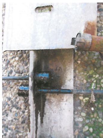
Foto 28. Låse afdækket og smurt med korrosionsbeskyttelse.
