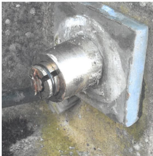
Foto 6. Kabellås (CCL lås- – sådan skal den se ud under hættten.
