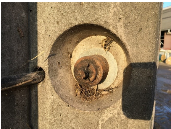
Foto 31. Lås hvor der ses korrosion på låsehus og ingen overfladebehandling.
