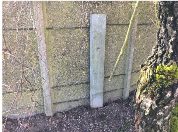
Foto 33. Afdækning af låse med stålskinne.
