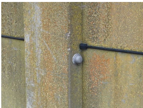
Foto 11. Afdækning på Spæncom beholder i form af plastafdækning sat i fugemasse.
