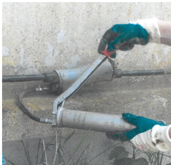
Foto 20. Efterfyldning af Dywidag lås med fedt.
