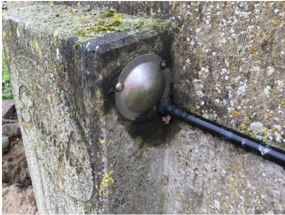
Foto 13. Afdækning på Spæcom beholder i form af stålafdekning med pakning.
